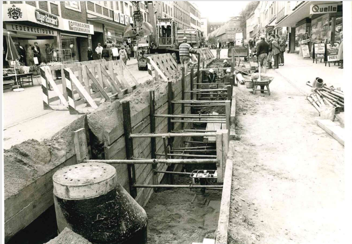
Erneuerung der Entwässerungsleitungen 1985
